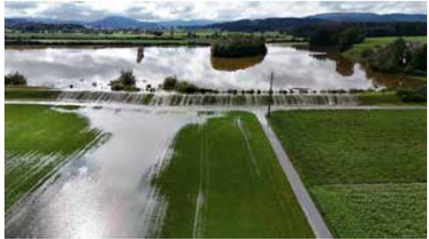
In den frühen Morgenstunden wurde auch das Becken West voll und begann an der Überströmkante auszulaufen. Um den Damm des Rückhaltebeckens zu entlasten, wurde zusätzlich die Abflussmenge zum Schwemmbach von der Behörde geringfügig erhöht.
